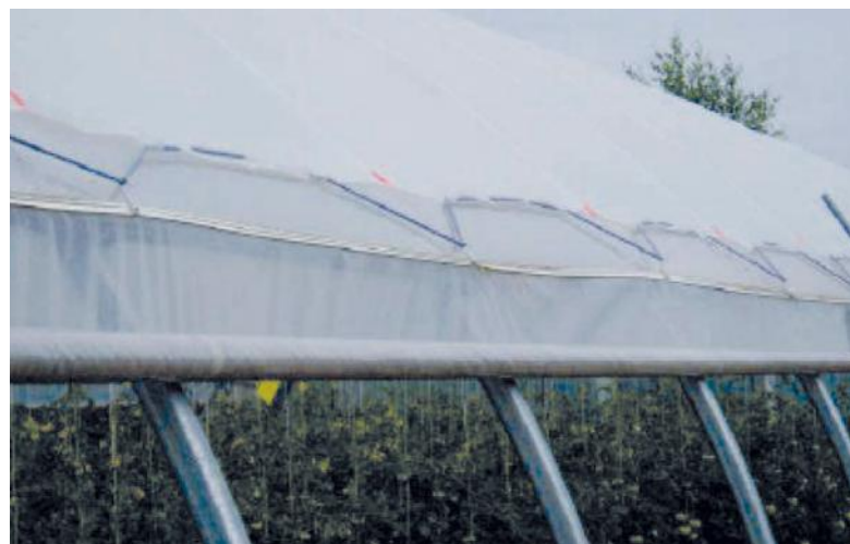
Fixation d'un filet d'ombrage. Source : Serail.
