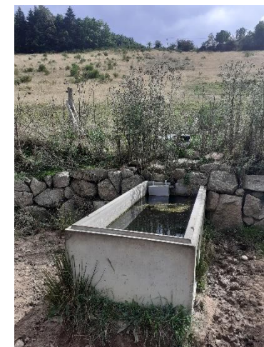
Figure 2. Bac d'abreuvement en béton récupérant l'eau d'une source
