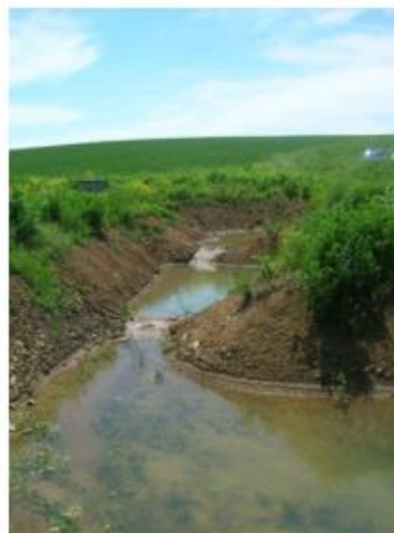
Figure 6 : Dispositif « linéaire en trois bassins »
