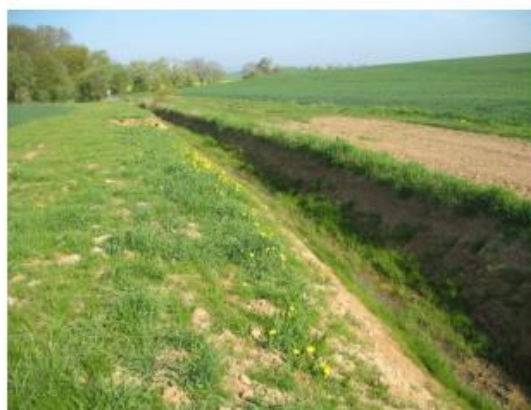
Figure 2 : Dispositif « fossé long non re-végétalisé »
